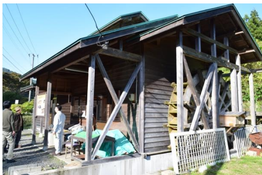
【水車小屋の外装】
