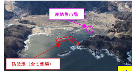
<東日本大震災津波の被災状況（田老漁港）>
