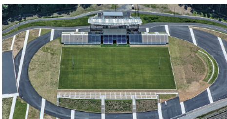
完成した釜石鵜住居復興スタジアム
