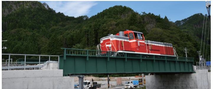
試験走行を行うディーゼル機関車(写真提供:JR東日本盛岡支社)
