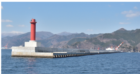
完成した北堤
