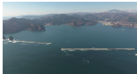
湾口防波堤の全景
