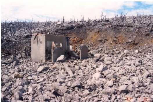
三宅島2000年噴火 噴石により破壊された建物（アジア航測撮影）
