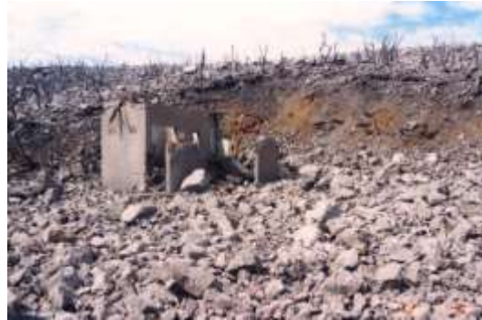
三宅島2000年噴火 噴石により破壊された建物（アジア航測撮影）
