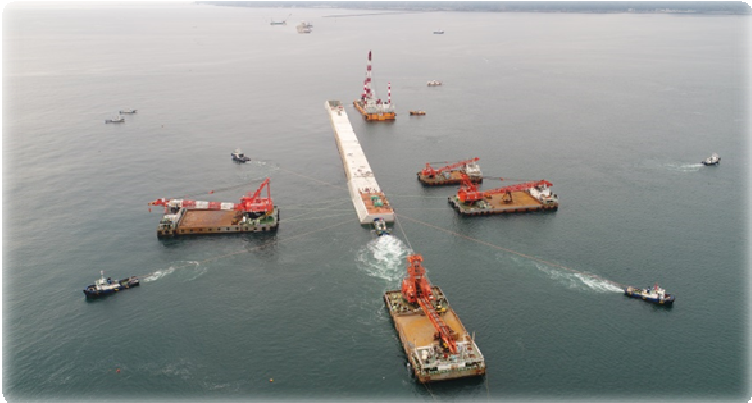
湾口防波堤の整備が進み、 利用拡大
