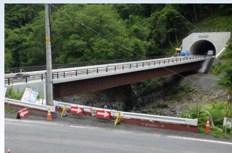
一般国道 281 号案内工区 (H29. 11. 19 開通予定 久慈市)
