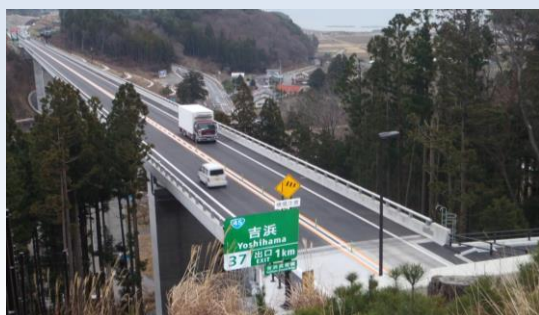
三陸沿岸道路（吉浜道路） (H27. 11. 29 開通)
