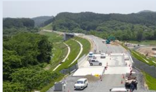
三陸沿岸道路（山田宮古道路） (H29. 11. 19 開通予定)
