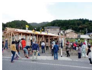
崎浜番屋「浜らいいん」建築の様子
