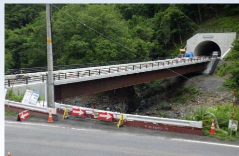
一般国道 281 号案内工区 (H29. 11. 19 開通予定 久慈市)
