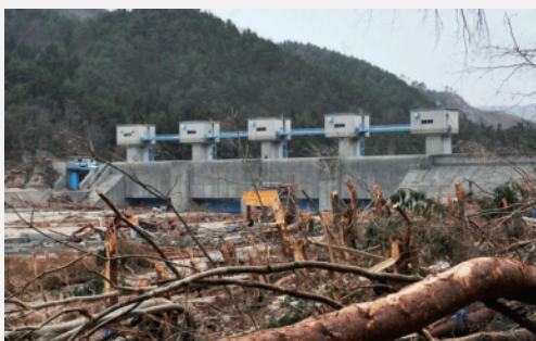
津波被害を最小限に抑えた普代水門（写真提供：普代村）
