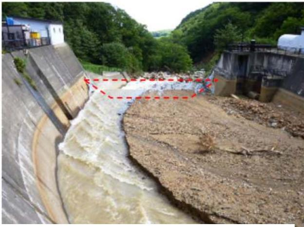
【取水口ゴム堰付近に大量に堆積した土砂】
