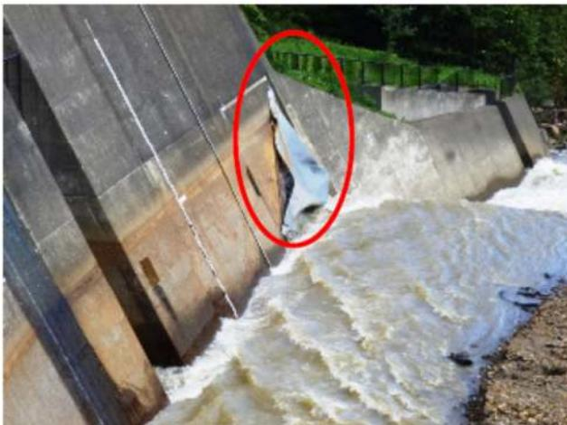
【取水口ゴム堰の固定金具カバー破損状況】
