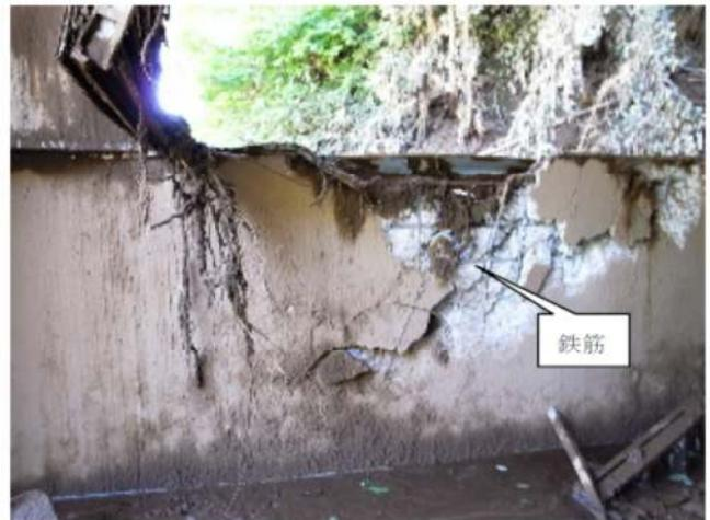
【主要変圧器室の側壁の損壊状況】
