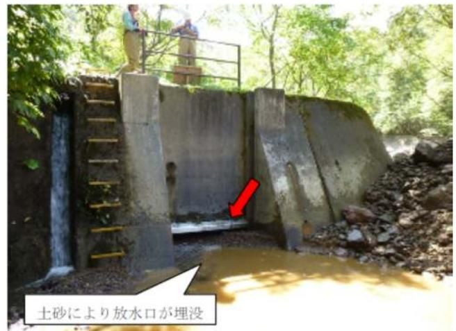
【放水口の土砂による閉塞状況】
