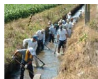
水路の泥上げ
