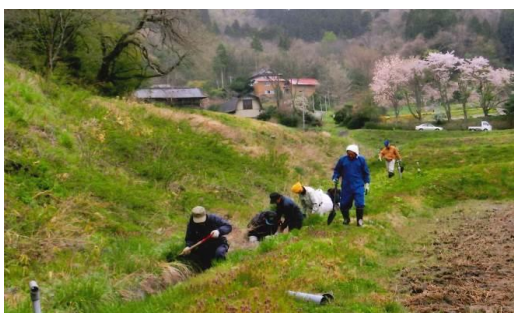
共同活動による水路の泥上作業
