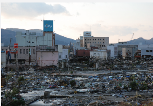
被災した中心市街地（写真提供：大船渡市）
