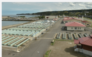
復旧後の「岩手県栽培漁業協会種市事業所」
