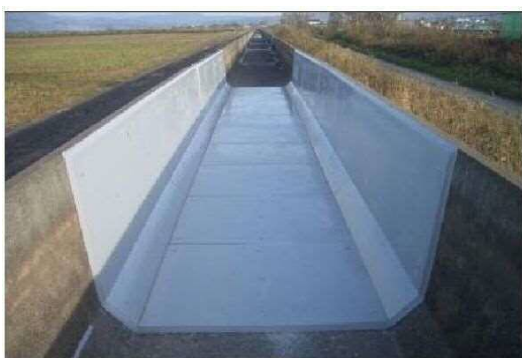
取付水路（FRPM 板パネル接着）
