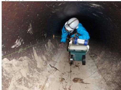
管内部のたわみ状況の調査
