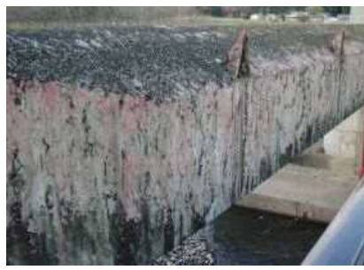
洪水吐ゲート（塗装劣化）
