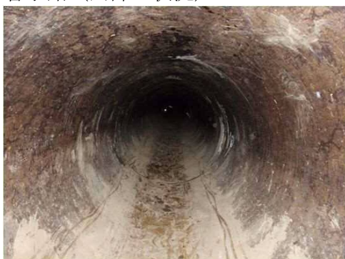
管水路（内部の状況）
