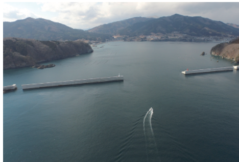
完成した大船渡港湾口防波堤（写真提供：国土交通省東北地方整備局釜石港湾事務所）
