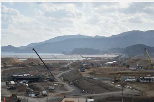
復興工事が進む陸前高田市街地（H29.2月撮影）
