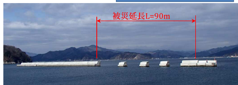
白浜(鶴住居)漁港(第2防波堤)
