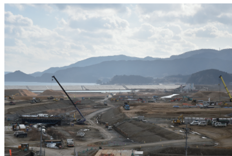
高台から見た防潮堤全景
