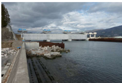
整備が進められている気仙川水門
