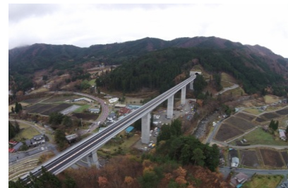
<復興道路の整備>
