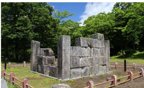
＜橋野鉄鉱山 三番高炉跡＞
