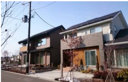
＜県産材活用をした新築住宅＞
