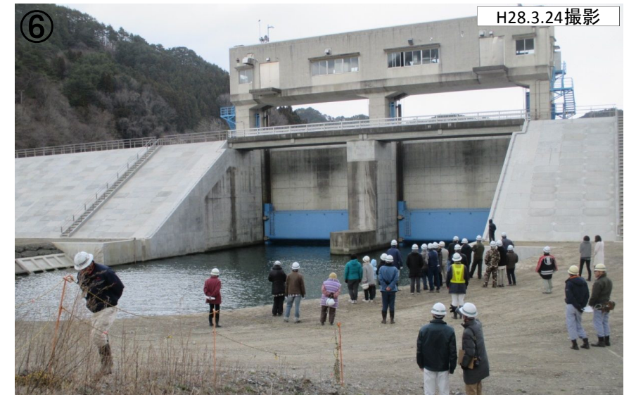
⑥ H28.3.24撮影 ・H28.3.24 水門完成後の住民への見学会の状況(ゲート開閉操作)
