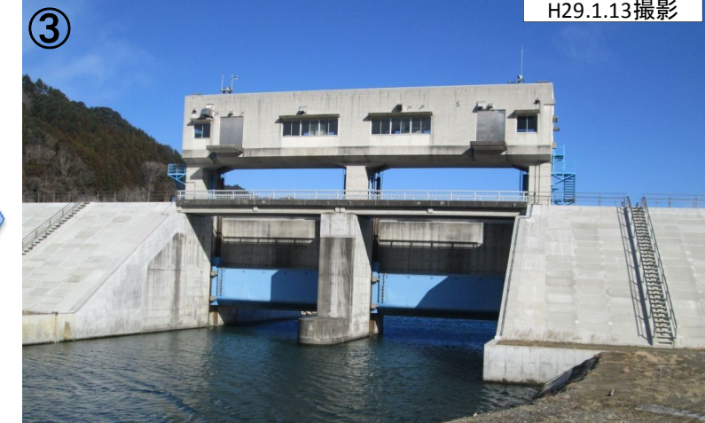
③ H29.1.13撮影 ・水門完成状況(②拡大)
