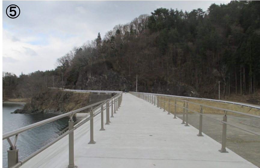
⑤ H29.1.13撮影 ・防潮堤天端完成状況(右岸側)
