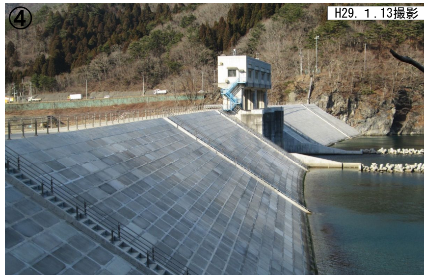
④ H29.1.13撮影 ・水門・防潮堤完成状況(右岸海側から撮影)
