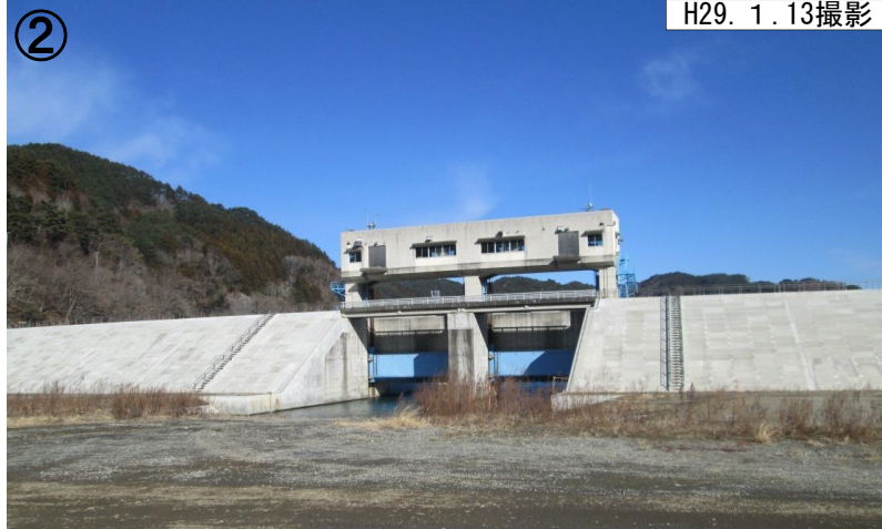
② H29.1.13撮影 ・水門・防潮堤完成状況(川側から撮影)
