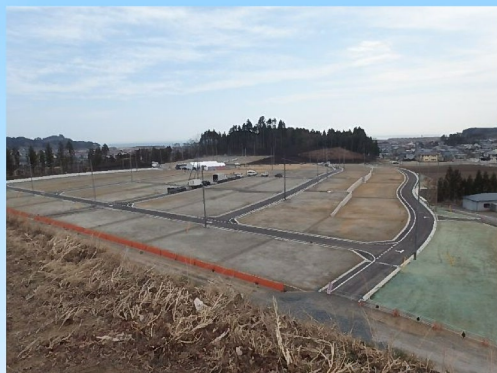
高台造成工事の完成状況（野田村城内地区）
