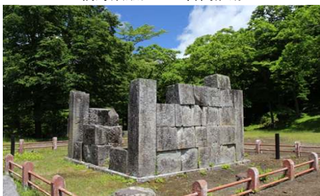
<橋野鉄鉱山 三番高炉跡>
