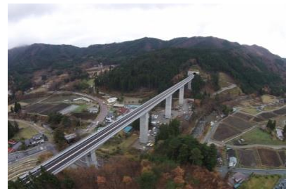
<供用済みの復興道路>
