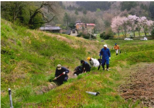
( 用水路泥上げ作業 )
