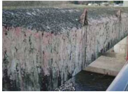
洪水吐ゲート（塗装劣化）
