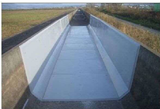
取付水路（FRPM 板パネル接着）
