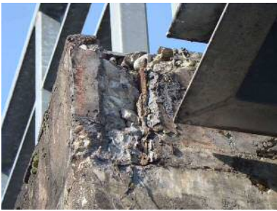
土砂吐堰柱（鉄筋露出）
