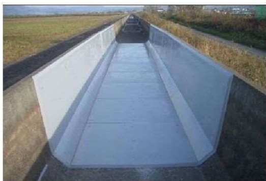
開水路（FRPM板パネル接着）
