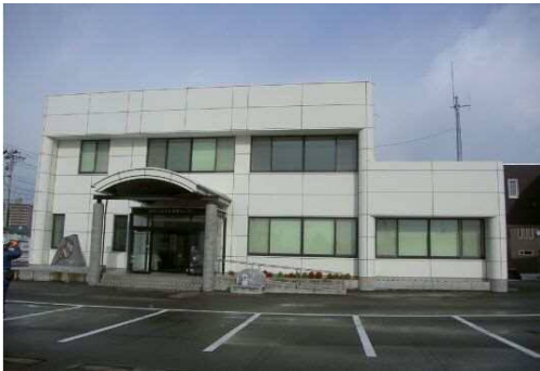
用水管理センター（雨漏り）
