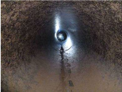
管水路（内部の状況）
