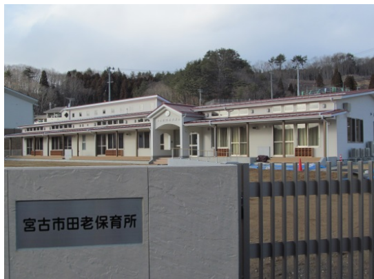
【田老保育所正面から】
