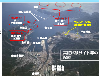
【海洋再生可能エネルギー実証フィールド】
