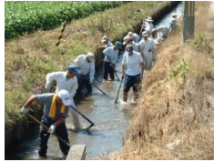
水路の泥上げ
