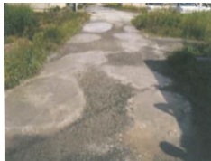
農道の窪みの補修
