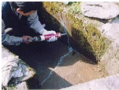
水路のひび割れ補修
