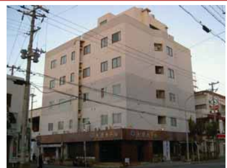
津波避難ビル
