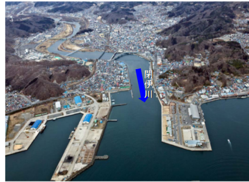
被災前状況 H22.3.9 撮影
