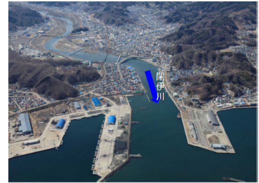
被災後状況 H23.3.28 撮影
