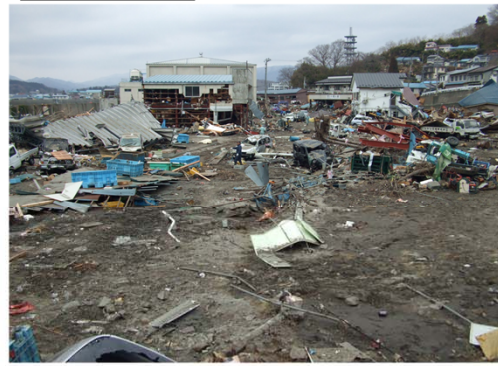
閉伊川左岸河口部被災状況
