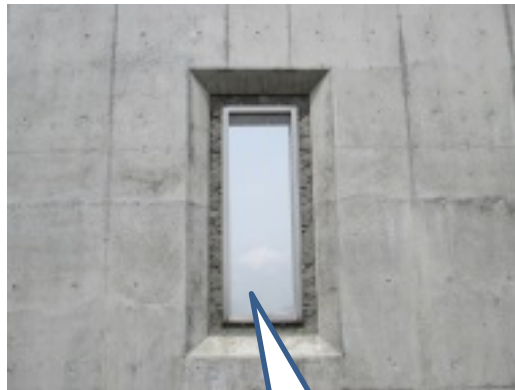
スリット窓を設置
