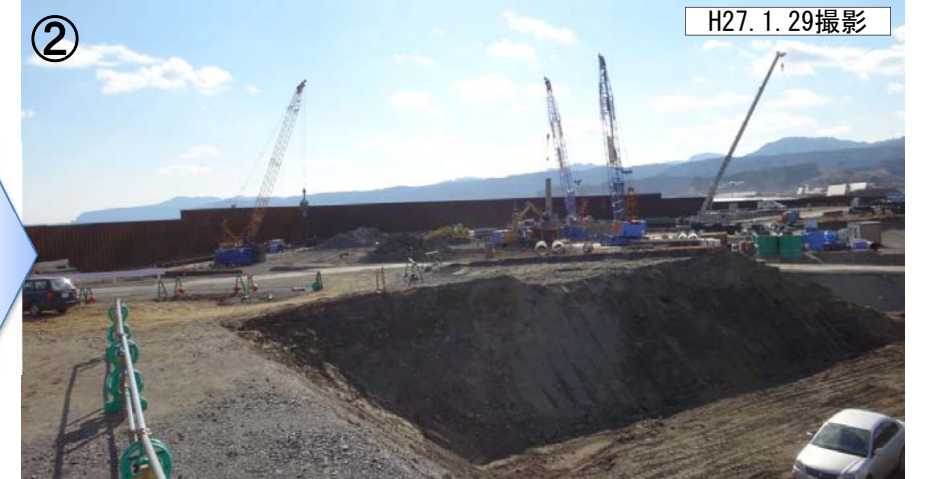
・仮締切矢板の設置完了状況
