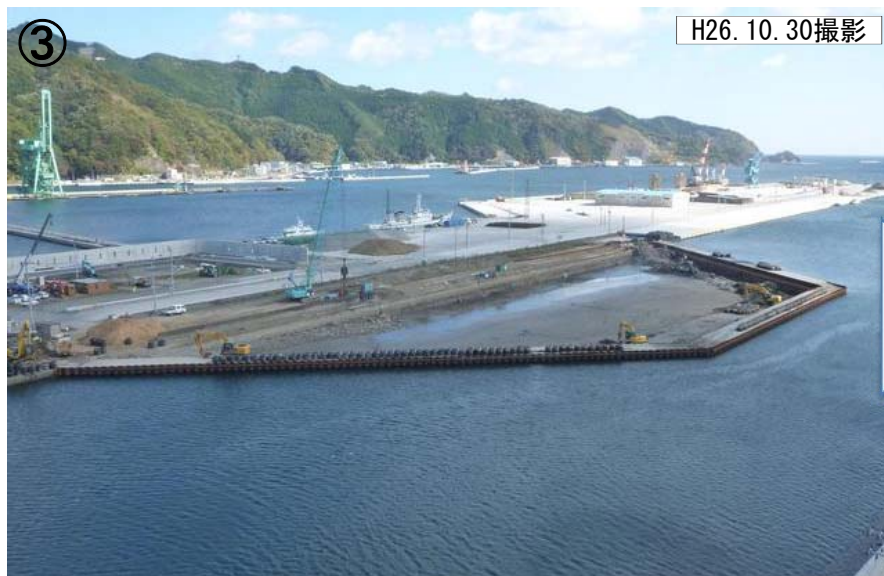
・仮締切内掘削状況
