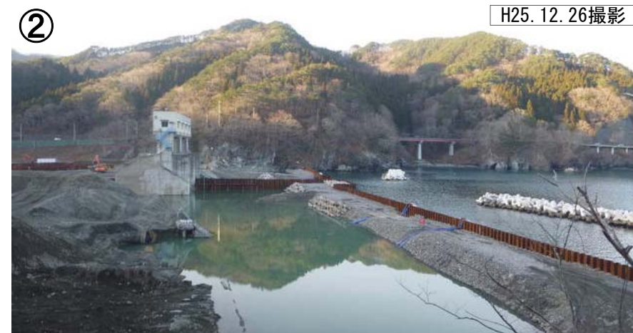
・右岸防潮堤仮締切施工状況 H25.12.26撮影
