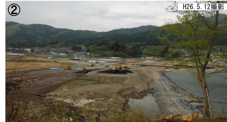
② 地盤改良準備工(右岸側防潮堤)
