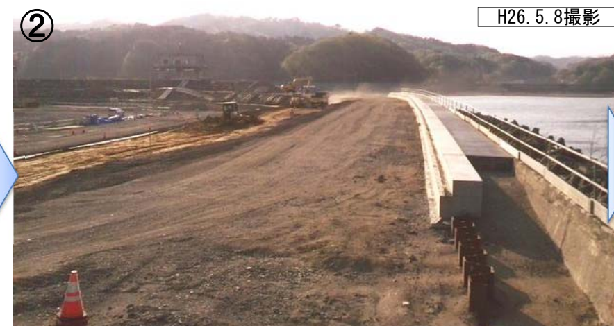
② H26. 5. 8撮影 ・起点から150mの築堤施工状況
