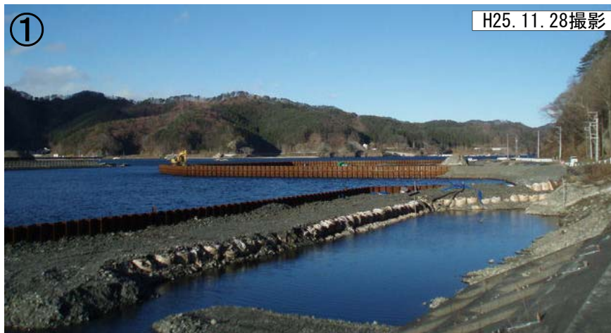
① 仮締切(第一期:右岸側)施工状況
