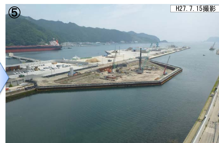
掘削完了→水門等基礎杭施工状況
