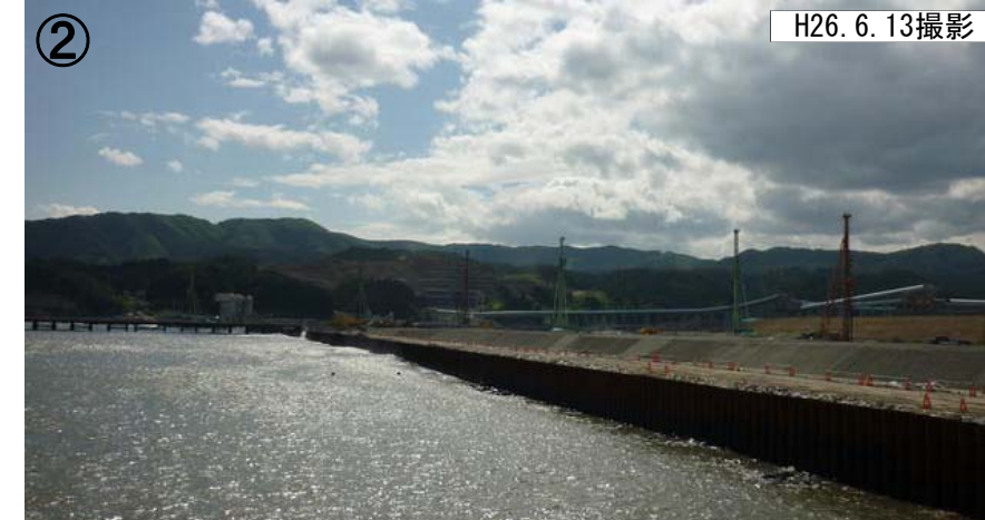
② 第一線堤前面仮締切状況 第二線堤地盤改良施工状況
