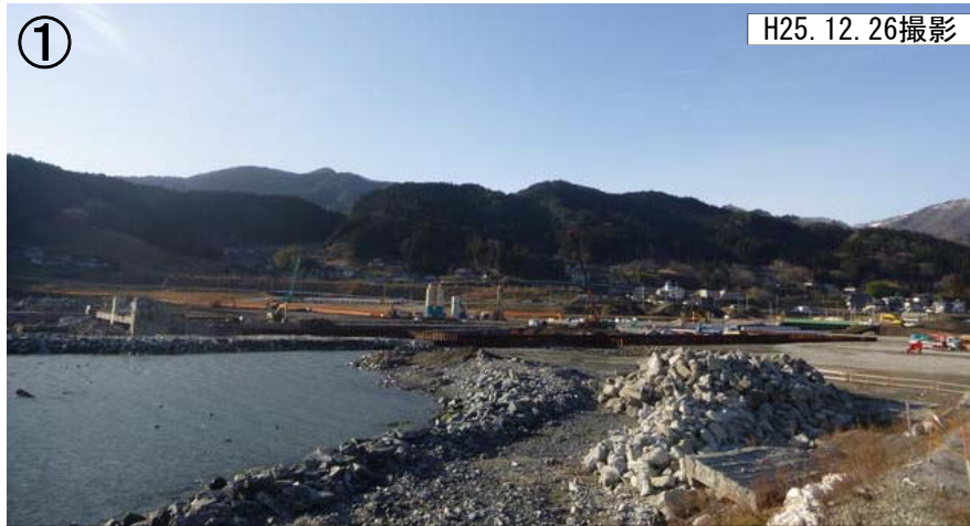
① 切替水路設置状況(左岸側から浦浜川を望む)
