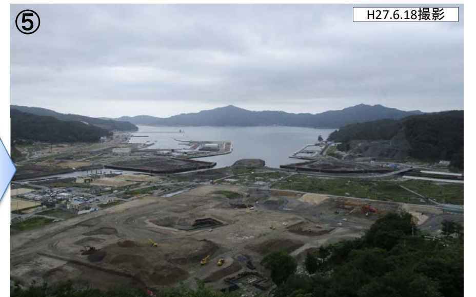
⑤ 施工箇所全景：小槌川水門撤去完了
