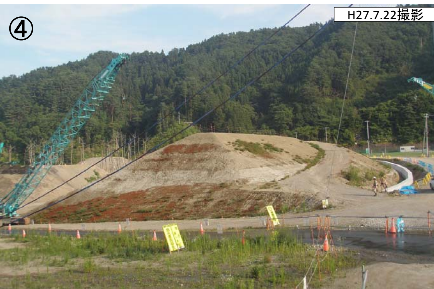
④ 右岸盛土施工状況
