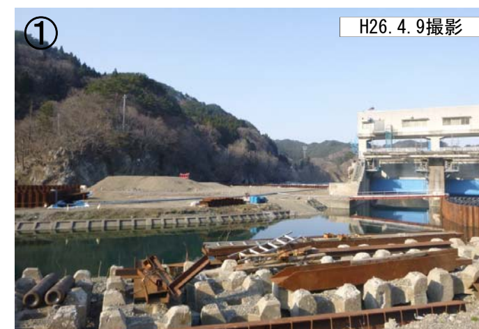
① ・左岸防潮堤取壊し状況 H26.4.9撮影
