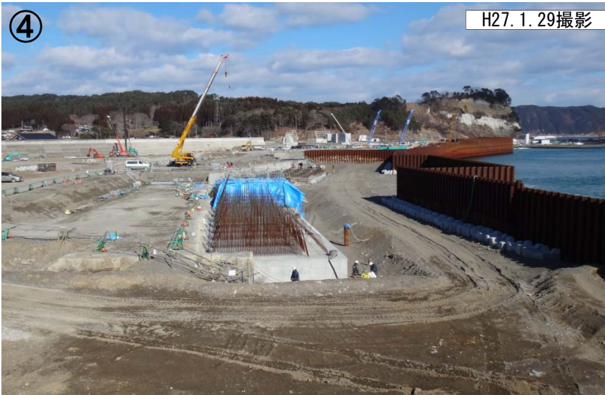
・起点側から撮影(南⇒北) ・防潮堤底板コンクリート打設・養生及び本体配筋状況
