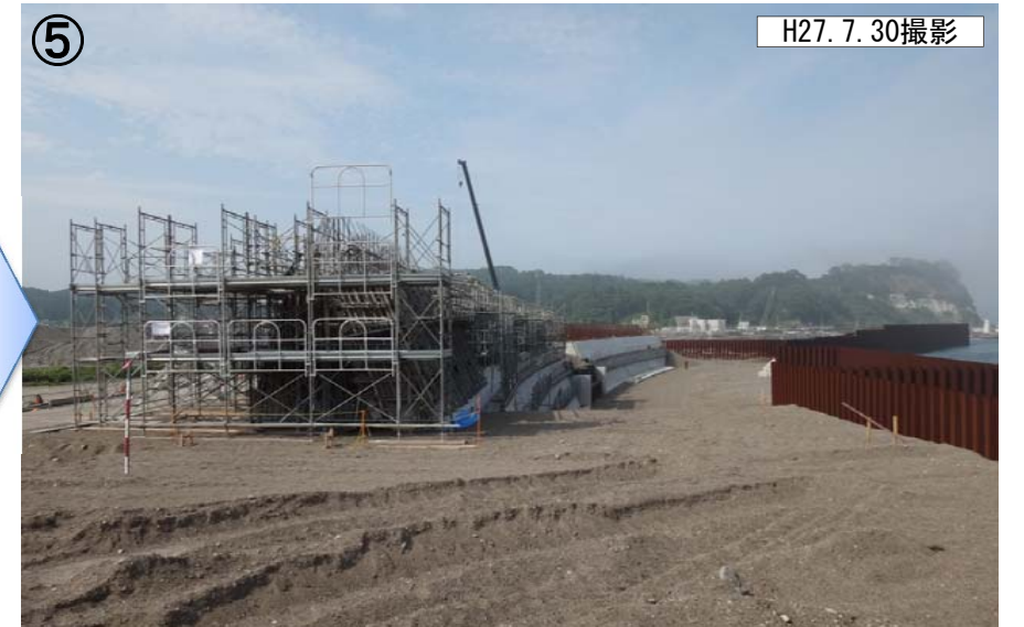
・起点側から撮影(南⇒北) ・防潮堤躯体(海側)コンクリート打設・養生及び配筋状況
