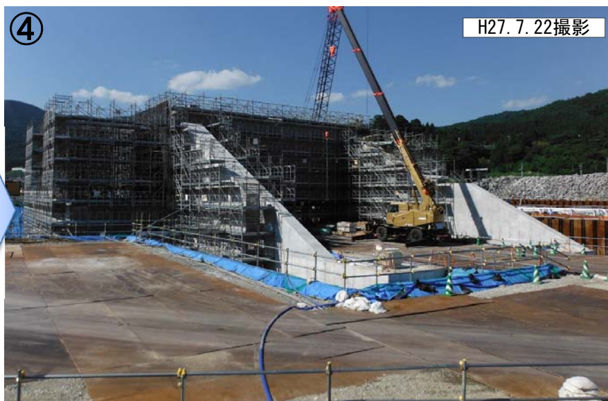
④ 浦浜川水門施工状況(水門下流側より)
