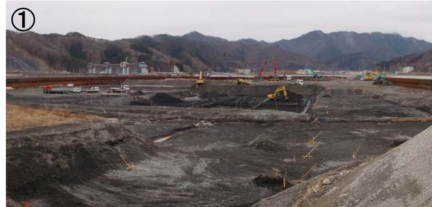
① 大槌川水門仮締切内：水門基礎部掘削状況
