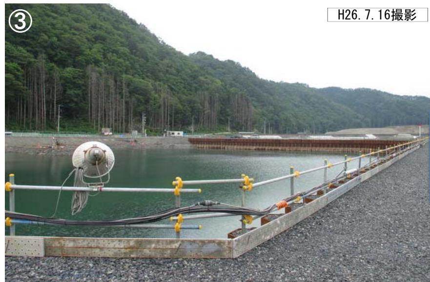
③ 仮締切内排水及び整正状況
