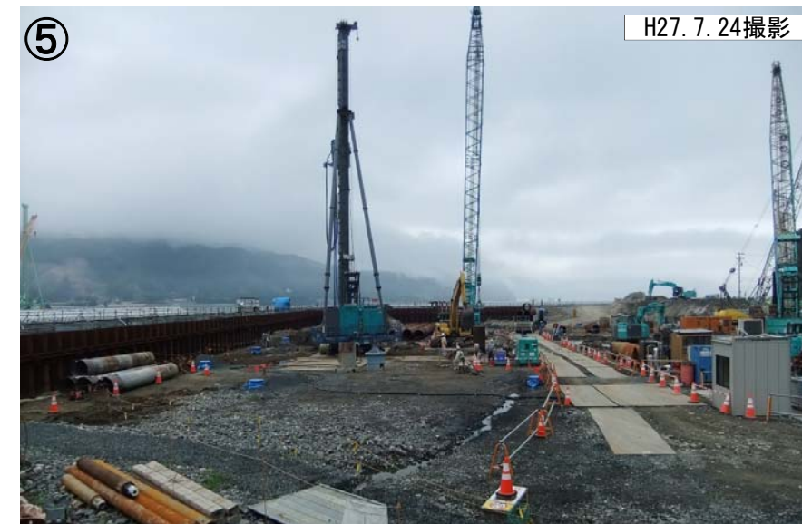
⑤ 基礎杭工施工状況
