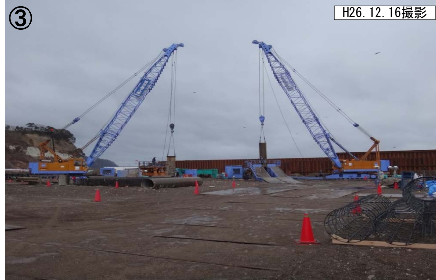
・水門部基礎杭の設置状況（水門の延長は約100m）
