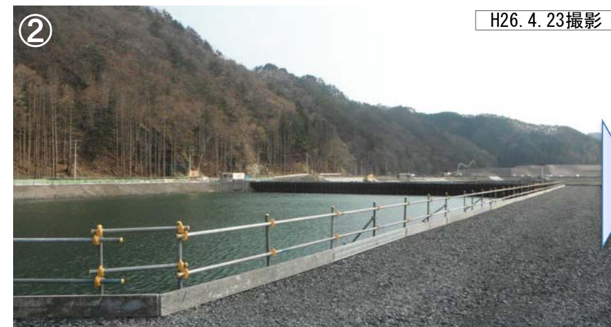
② 仮締切(第一期:右岸側)完了
