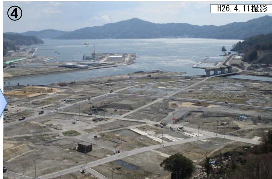
④ 施工箇所全景
