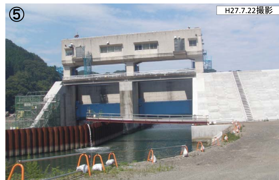
水門及び左右岸防潮堤施工状況 H27.7.22撮影
