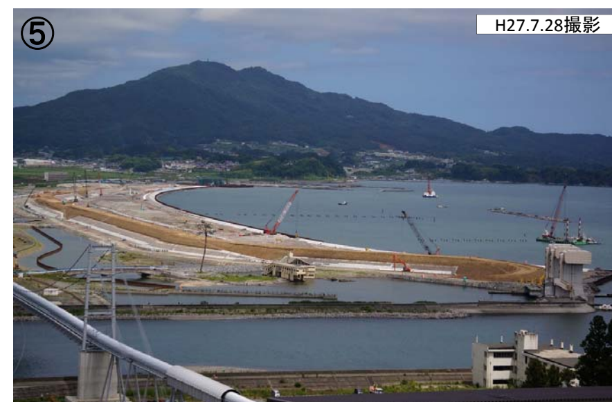
⑤ 第一、第二線堤施工状況(遠景)
