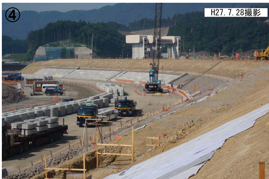
④ 第二線堤施工状況
