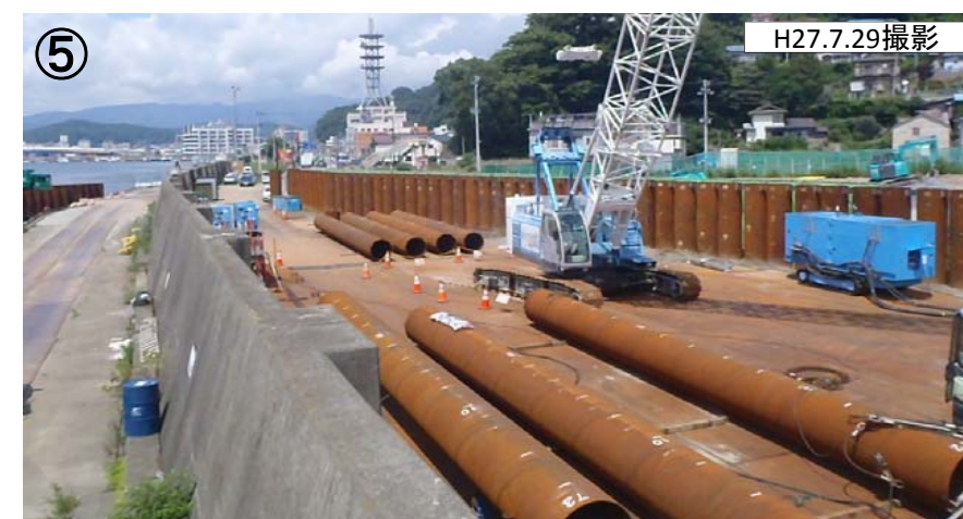
⑤ 左岸側土留鋼管杭設置状況(下流から上流望む)
