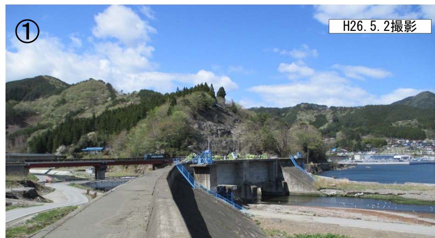
① 既設水門状況(右岸側から望む)
