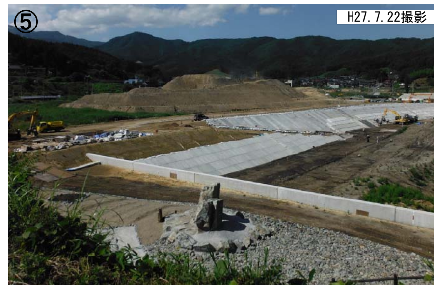
⑤ 右岸防潮堤施工状況
