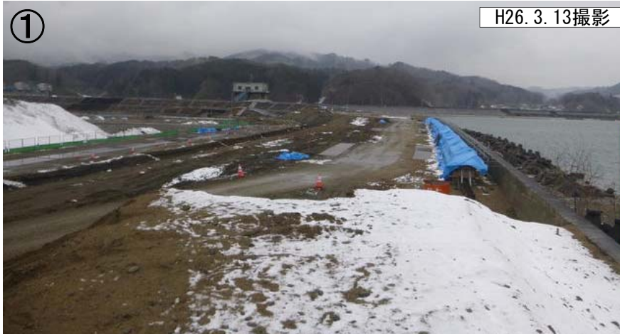
① H26. 3. 13撮影 ・起点から150mの築堤準備状況
