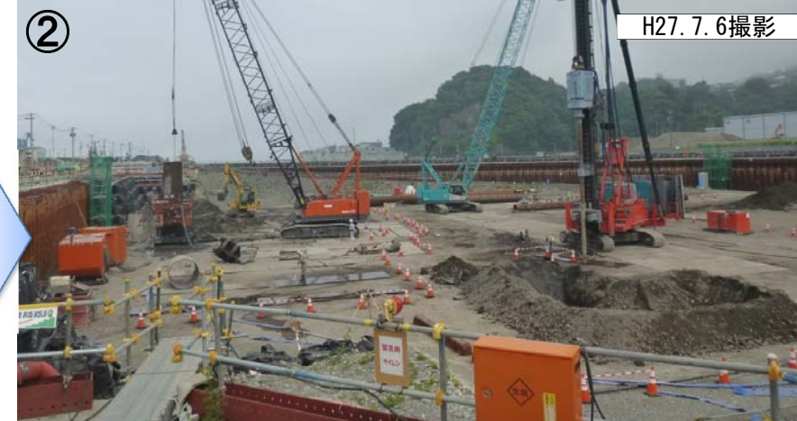
水門等基礎杭施工状況
