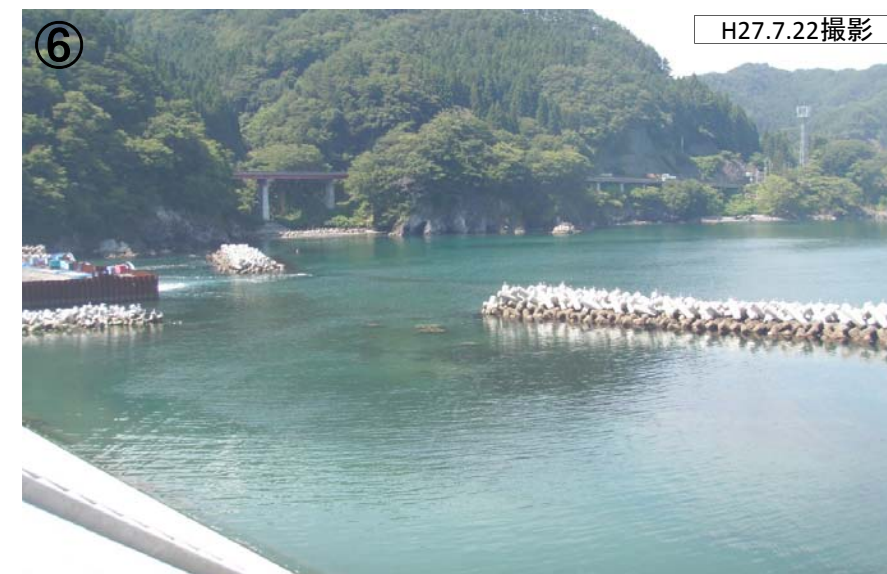
防潮堤前離岸堤完成 H27.7.22撮影
