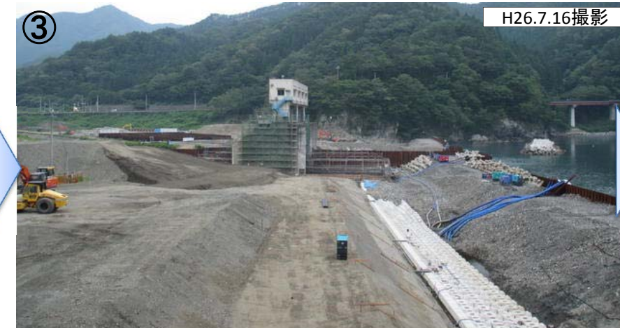
・表法整形及び均しコンクリート施工状況 H26.7.16撮影
