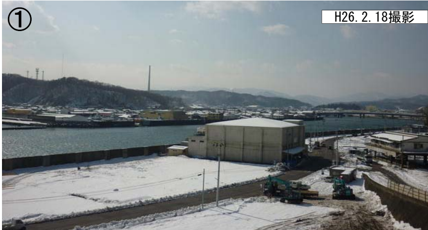
① 水門後締切施工状況(左岸下流より望む)
