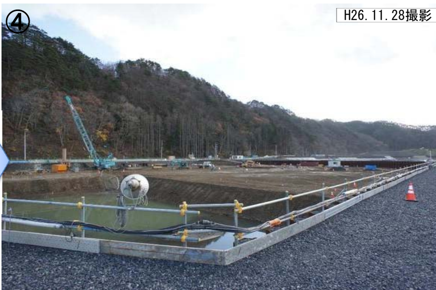
④ 仮締切内排水及び整正状況
