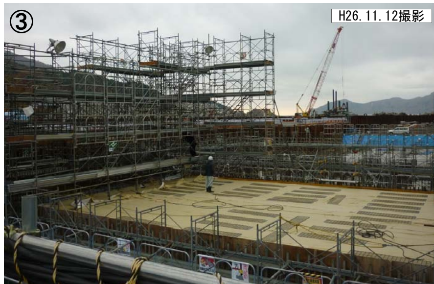
③ 浦浜川水門配筋状況(水門上流側より)
