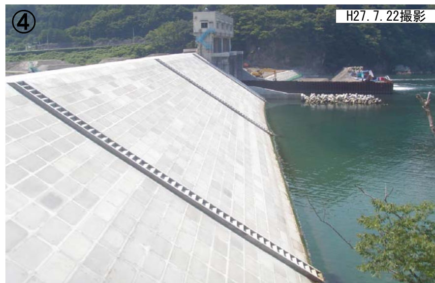
右岸防潮堤完了 H27.7.22撮影
