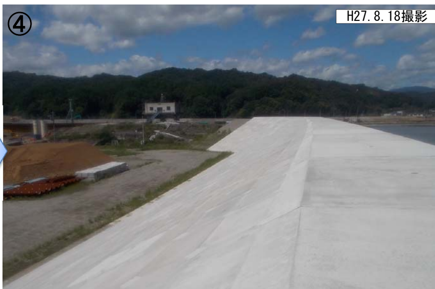
④ H27. 8. 18撮影 起点側(津軽石川水門)から150mまでの区間について、築堤被覆完了
