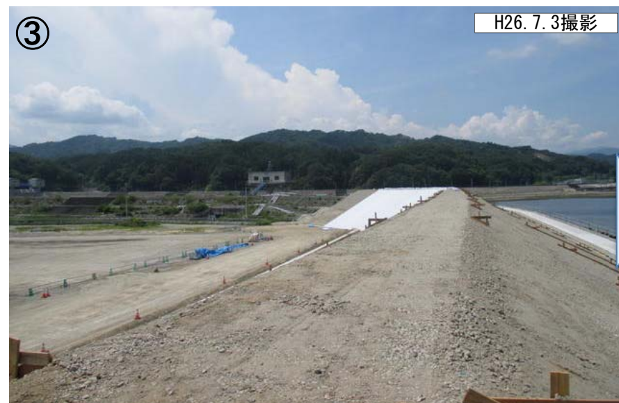
③ H26. 7. 3撮影 ・起点から150mの築堤完了状況 ・盛土材は、近隣で宮古市が施行する防災集団移転促進事業の建設発生
