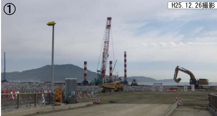
① 資材搬入用栈橋施工状況
