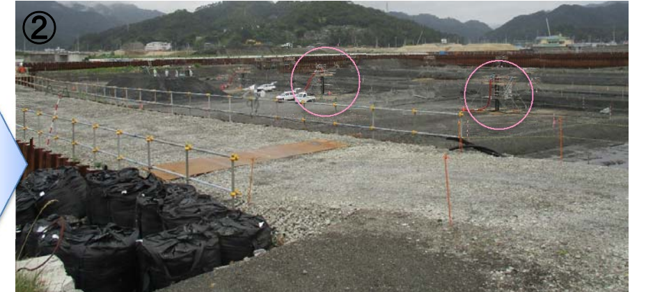
② 大槌川水門仮締切内：水門部地下水低下のため井戸より排水中
