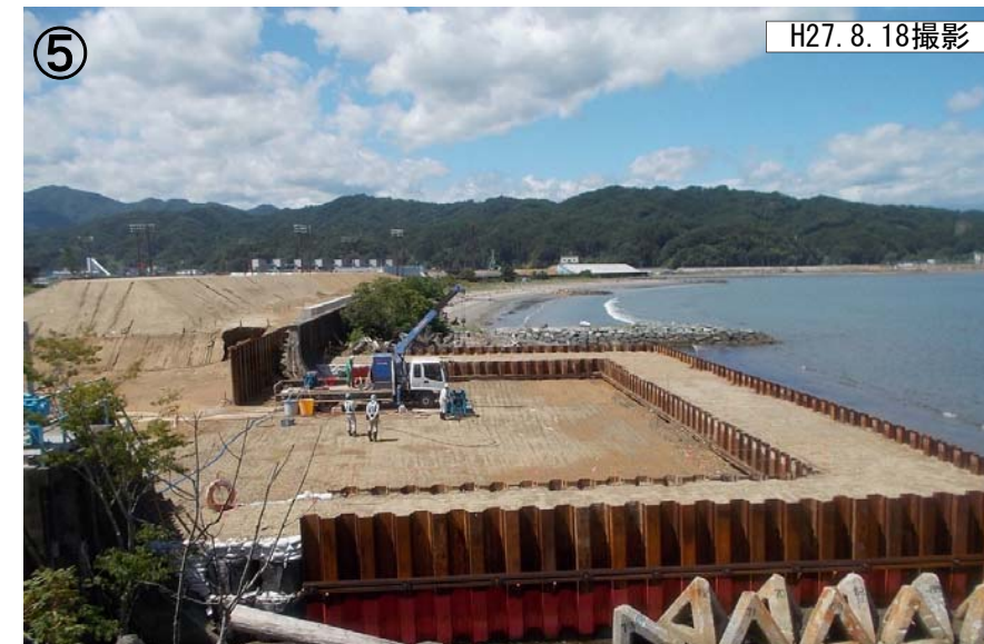
⑤ H27. 8. 18撮影 終点側の水門に係る仮締切が完了 築堤盛土が一部区間で完了⇒護岸に着手
