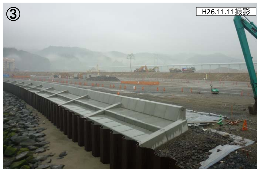
③ 第一線堤施工状況 第二線堤堤体盛土施工状況
