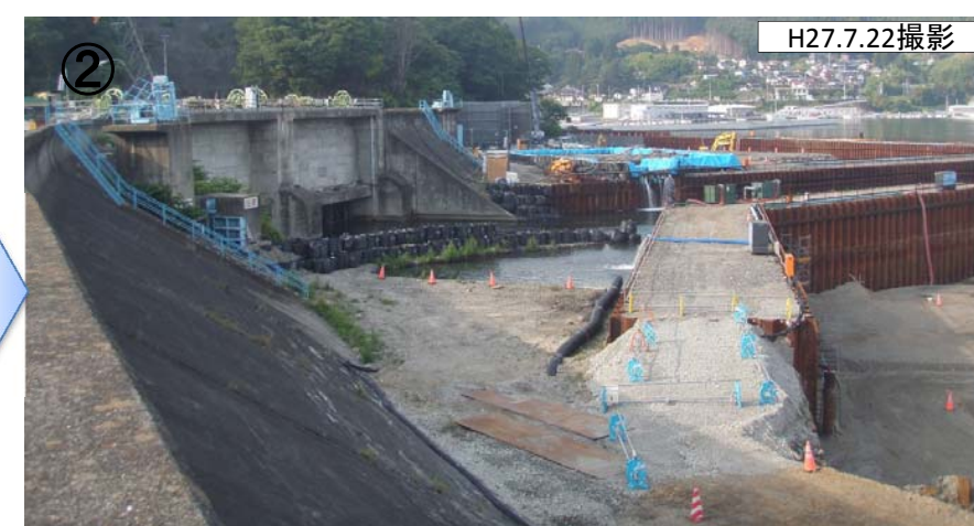
② 既設水門周辺の施工状況(右岸側から望む)
