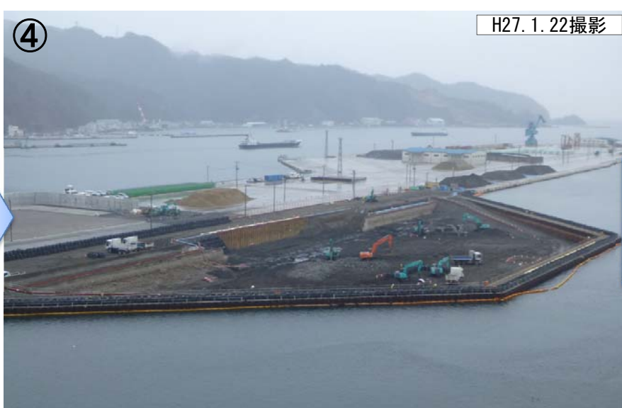
・仮締切内掘削状況
