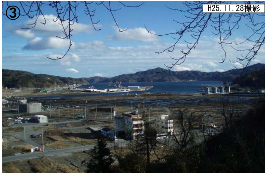
③ 施工箇所全景（高台から大槌川及び小槌川を望む）
