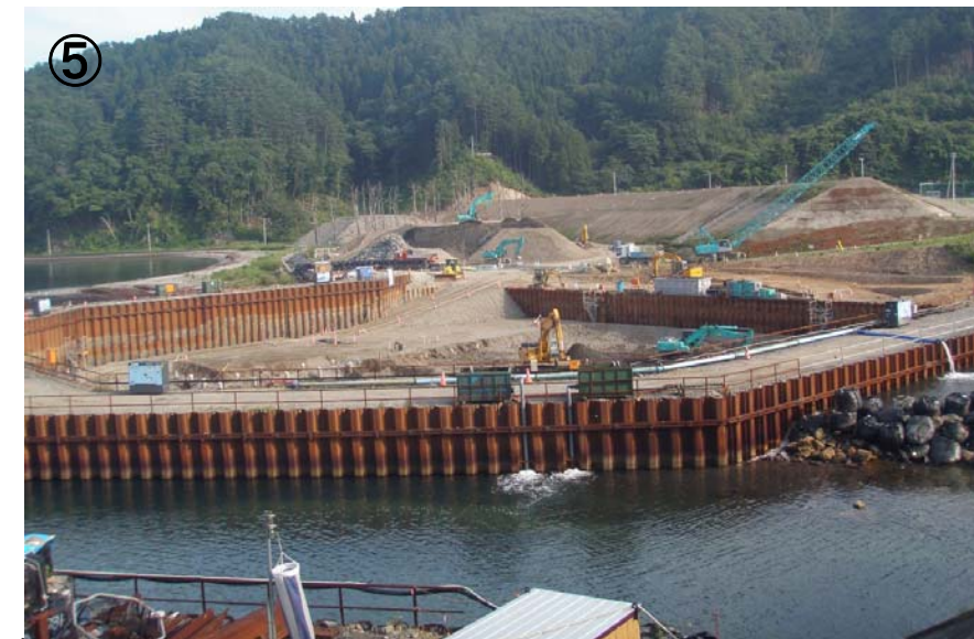
⑤ 水門施工状況
