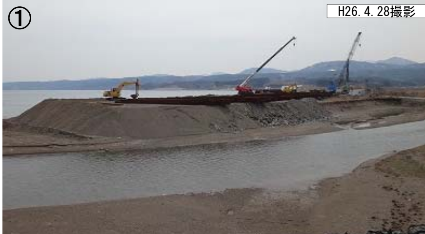
・仮締切矢板の施工状況
