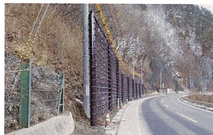
道路防災対策（一般国道281号）
