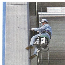
外壁の打診調査状況
