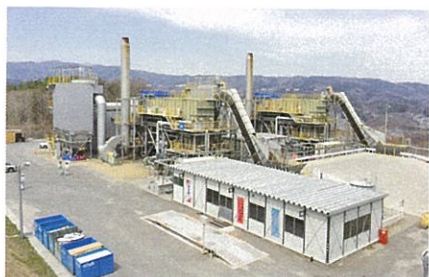
東日本大震災津波により発生した災害廃棄物の処理のために設置した仮設焼却炉
