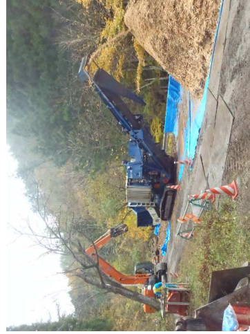
廃棄物の有効活用（伐根材を植生基材に加工）
