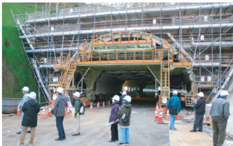
「宇部トンネル」工事現場見学の様子
