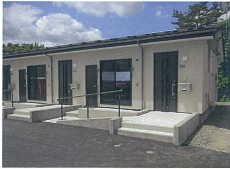
災害復興公営住宅 (岩泉町・森の越地区)
