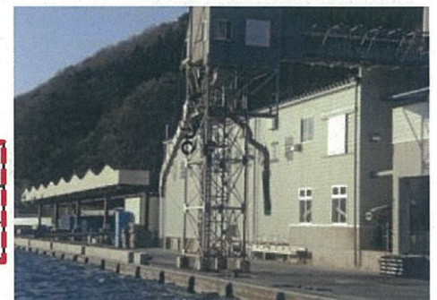
共同利用施設の復旧支援により整備した製氷・荷捌き施設(釜石市)
