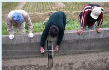
施設の機能診断
