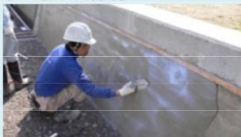
老朽化した水路壁のコーティング
