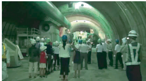
摂待第1トンネル工事現場見学の様子
