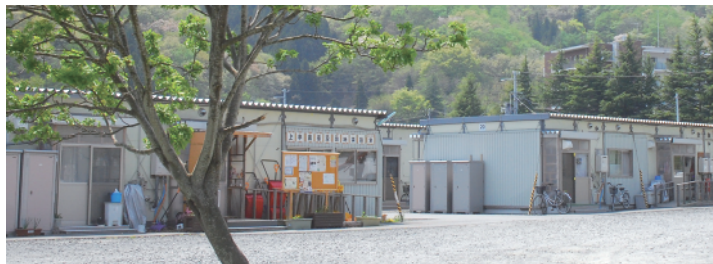
改修が予定されている上中島仮設住宅（釜石市）
