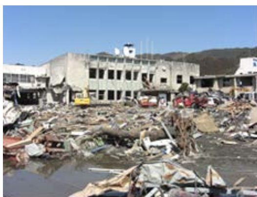
【津波により壊滅した大槌町役場】
