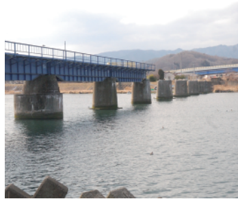
工事が始まる「山田線第34開伊川橋梁」
