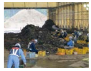
災害廃棄物の選別作業(釜石市 平成25年10月)
