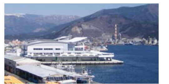
高度衛生管理型魚市場の整備(平成26年4月完成 大船渡魚市場)
