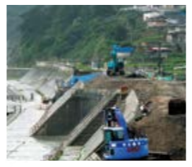
久喜漁港海岸災害復旧工事(久慈市 平成25年9月)
