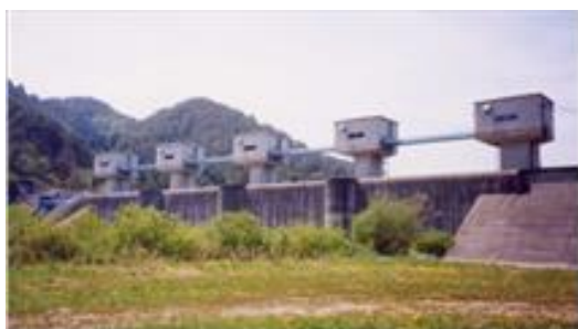
【普代村における津波被害を軽減した普代水門】
