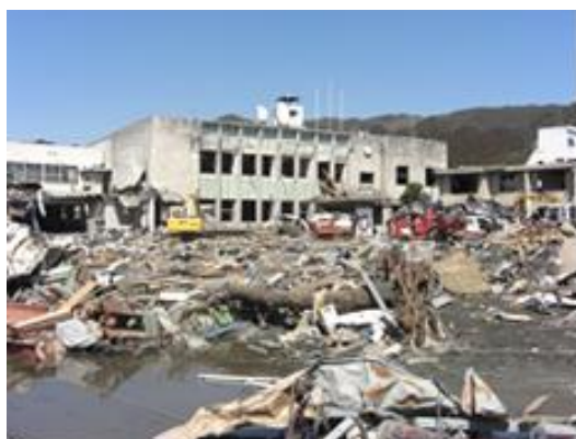
【津波により壊滅した大槌町役場】
