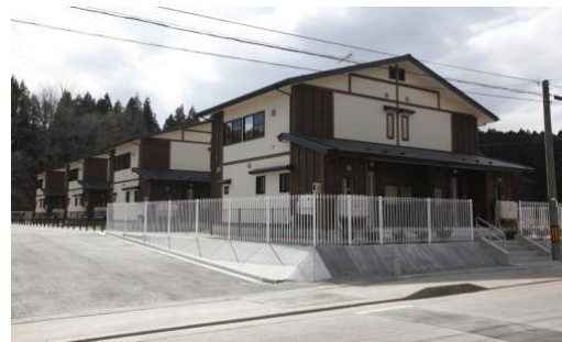
災害公営住宅 (野田村)
