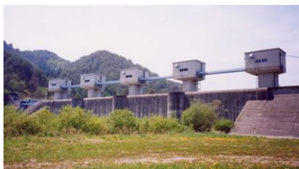
普代水門の全景
