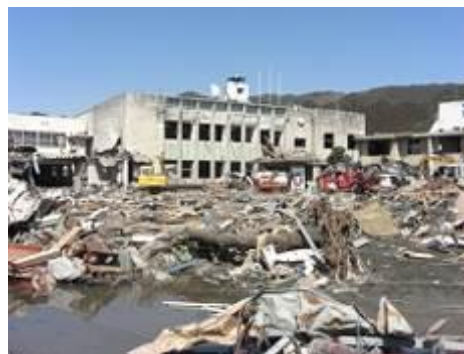
津波により壊滅した大槌町役場
