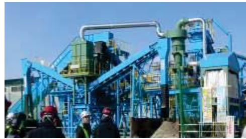
宮古市に設置した破碎・選別ライン（鹿島 JV）
