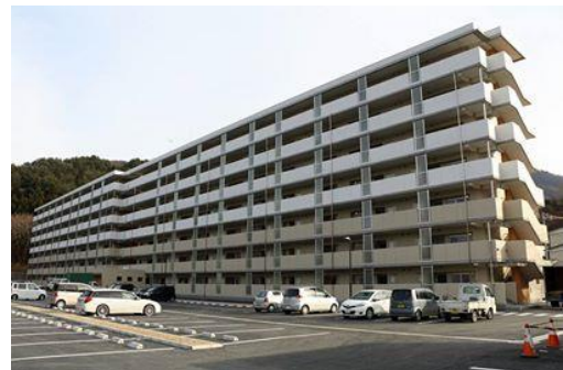
災害公営住宅 (金石町)
