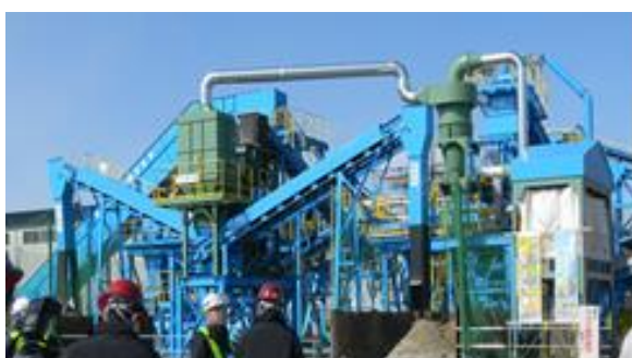
【宮古市に設置した災害廃棄物の破碎・選別ライン】
