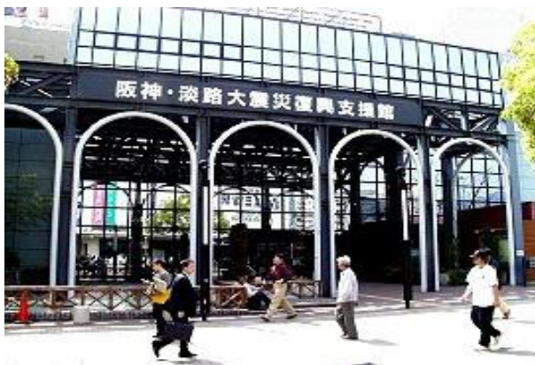
【阪神・淡路大震災復興支援館 (仮設)1996.7～2002.3】
