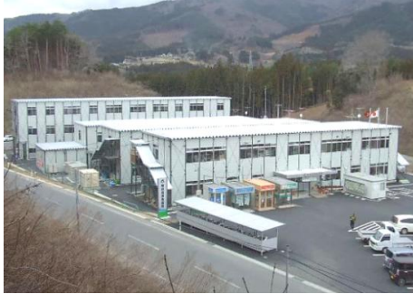
陸前高田市仮設庁舎
