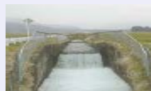
発電機設置前の水路
