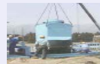
水車・発電機の設置
