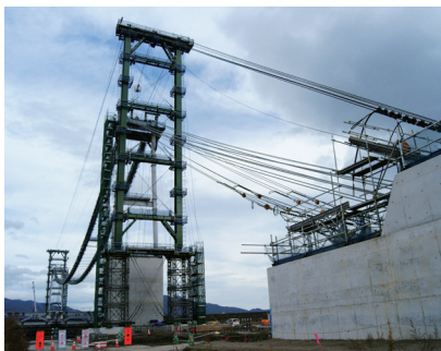
工事が進む ベルトコンベア用つり橋
