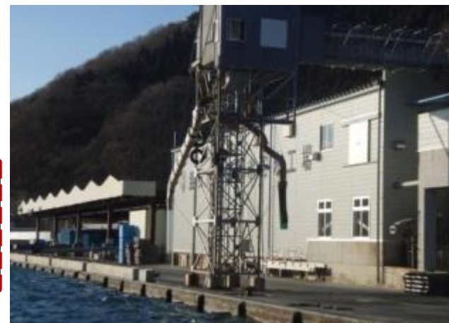
共同利用施設の復旧支援により整備した製氷・荷捌き施設(釜石市)
