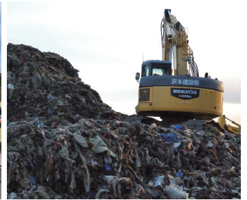
宮古地区災害廃棄物処理の様子
