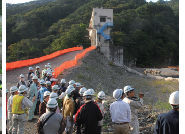
水海海岸災害復旧工事現場
